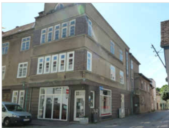
Eckhaus Krönchenhagen 27 mit den dahinterliegenden Gebäudeteilen der Backwarenfabrik
