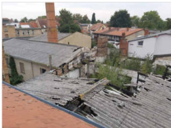
Blick aus dem Vorderhaus Krönchenhagen 27 in den Innenhof
