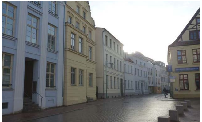
Straßenzug Am Berge 12 - 13 in Richtung Lange Straße 1-5 mit der Neugestaltung des Verkehrsraumes
