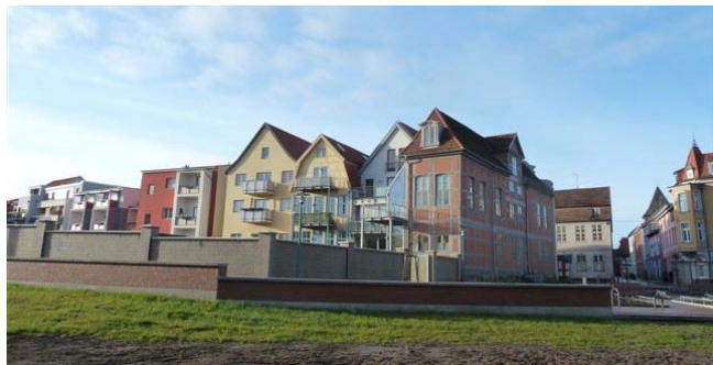
Blick von der Nebel in Richtung Am Berge Neugestaltung der Freifläche „Stadtmauer/Freiraum Am Berge“
