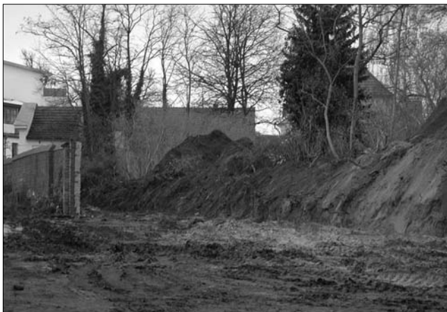
Sanierungsarbeiten an der Mauer des Gertrudenfriedhofes
